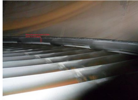
Inspection de la turbine
