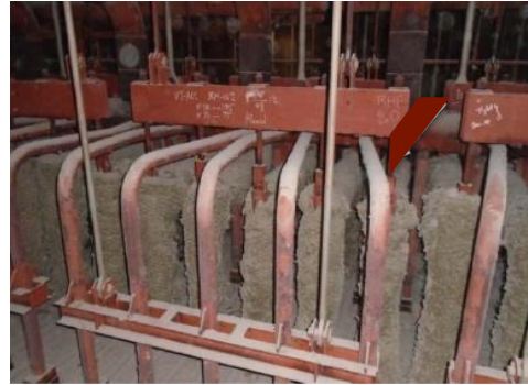
Inspection de la chaudière
