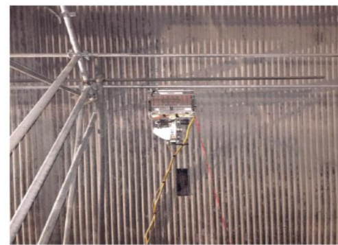
Contrôle et scanner des tubes de la chaudière par la méthode électromagnétique RFT*
