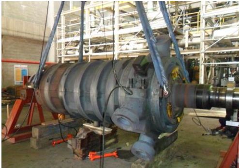
Manutention du corps HP de la turbine
